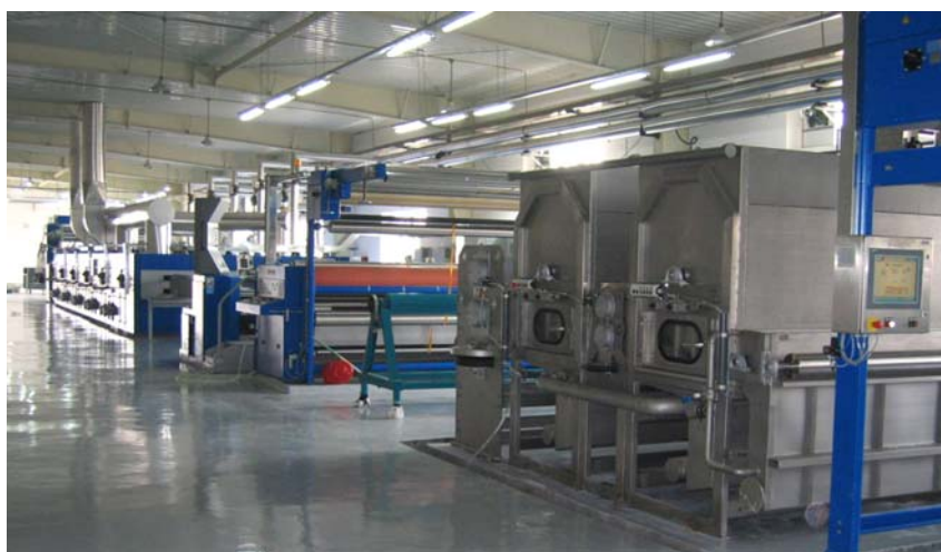
Abb. 1: Blick in die Produktionshalle bei Swisstulle (Qingdao), China
